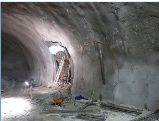
Figura 32 – Faseamento executivo durante a execução dos pilares de reforço na ligação à estação
