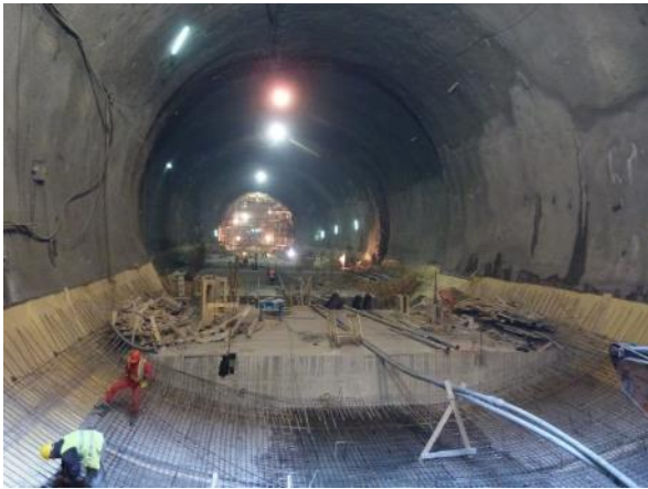
Figura 21 – Fases de instalação do sistema de impermeabilização e da montagem das armaduras do revestimento definitivo
