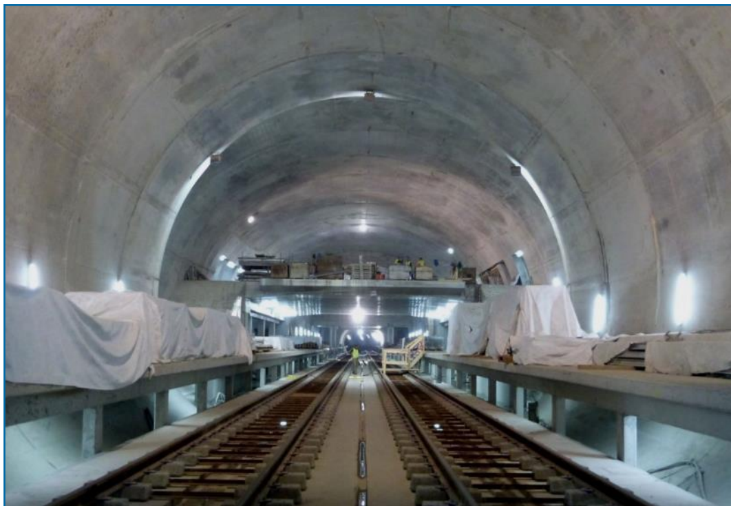
Figura 23 – Estação na fase final da empreitada de toscos
