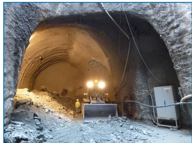
Figura 51 – Imagens da frente criada para ataque ao túnel de via a partir do acesso Sul da Estação Ali Boumendjel
