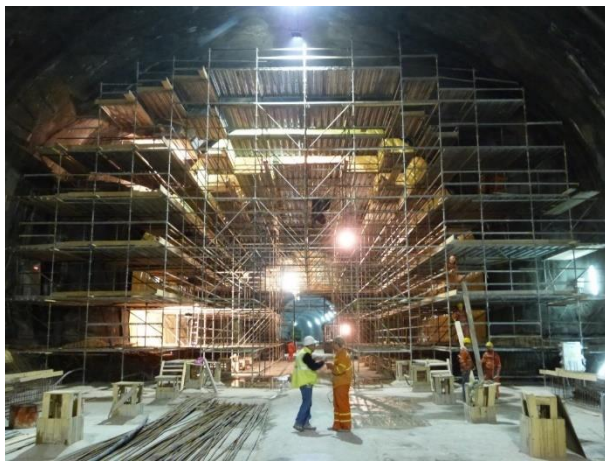
Figura 22 – Estruturas especiais para instalação do sistema de impermeabilização e para betonagem do revestimento definitivo
