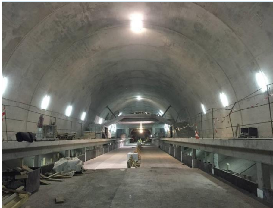
Figura 49 – Estação na fase final da empreitada de toscos
