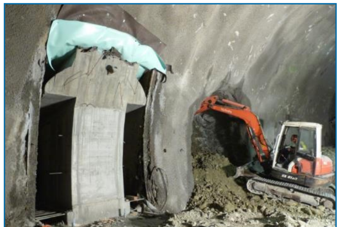
Figura 32 – Faseamento executivo durante a execução dos pilares de reforço na ligação à estação
