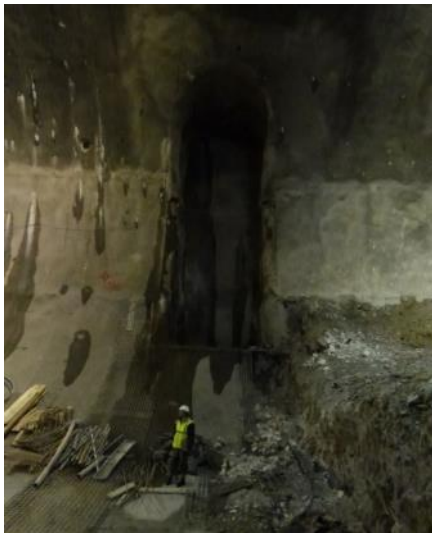
Figura 20 – Pormenores da escavação de um dos nichos para instalação dos elevadores e imagem do poço de ataque numa fase terminal das escavações no interior da estação
