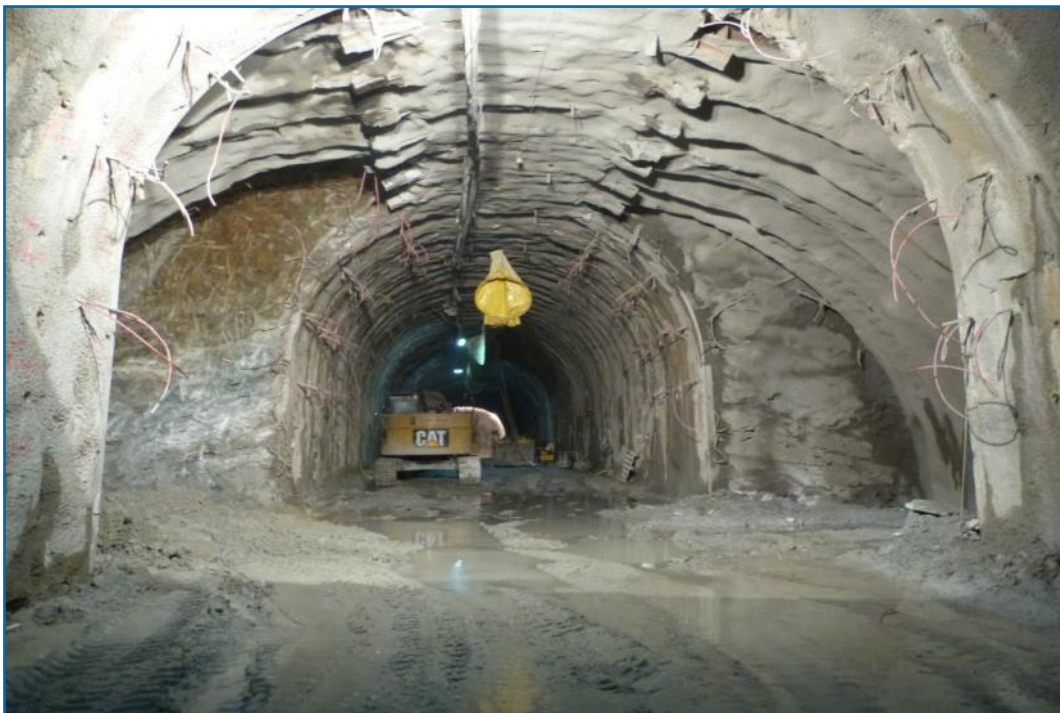
Figura 19 – Aspeto do alargamento inicial central concluído
