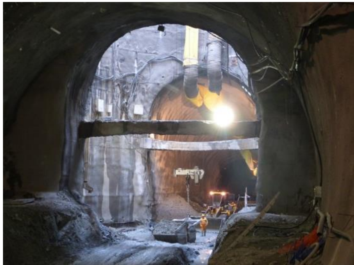
Figura 20 – Pormenores da escavação de um dos nichos para instalação dos elevadores e imagem do poço de ataque numa fase terminal das escavações no interior da estação
