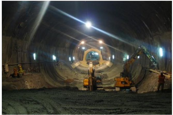
Figura 21 – Fases de instalação do sistema de impermeabilização e da montagem das armaduras do revestimento definitivo
