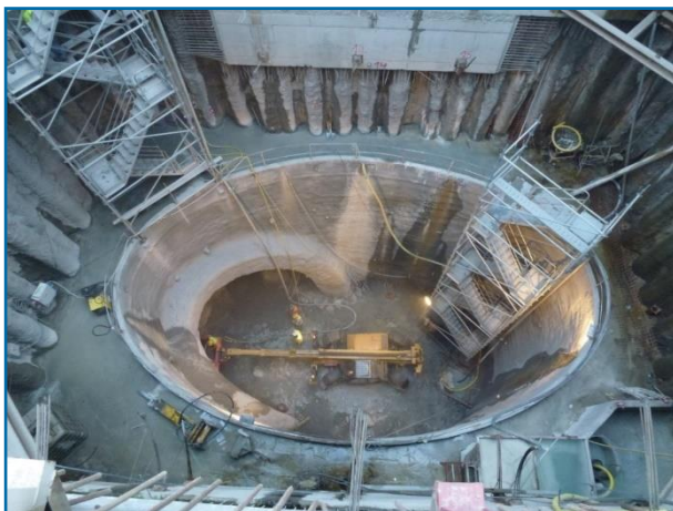
Figura 51 – Imagens da frente criada para ataque ao túnel de via a partir do acesso Sul da Estação Ali Boumendjel
