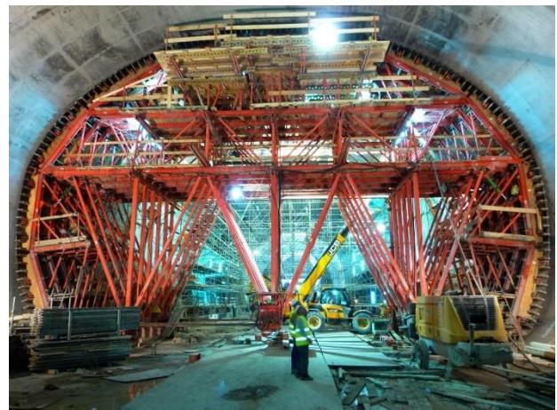
Figura 22 – Estruturas especiais para instalação do sistema de impermeabilização e para betonagem do revestimento definitivo
